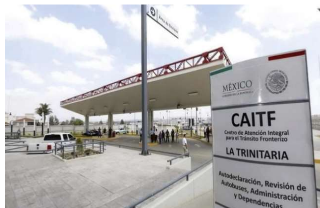
Imagen 13. Centro de Atención Integral para el Tránsito Fronterizo.
